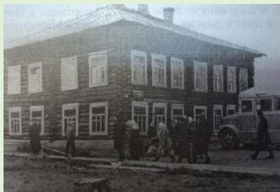
Старое здание автостанции. 1965 г.
