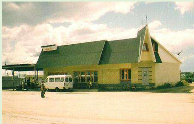
Автобусная станция с. Визинга. 2015 г.
