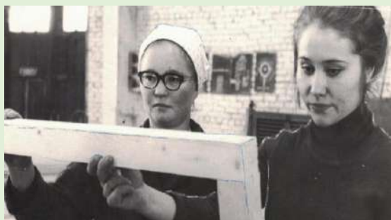
Бригада столяров-станочников ДОЗ с. Визинга (слева направо): А. Попова и Л. Полякова на сборке оконных реперлетов. 1979 г.
