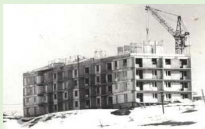
Строится 48-квартирный дом на ул. Советской. 1981 г.
