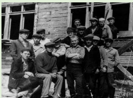
Бригада В.В. Чугаева возле ремонтируемого ими жилого дома в с.Визинга.
