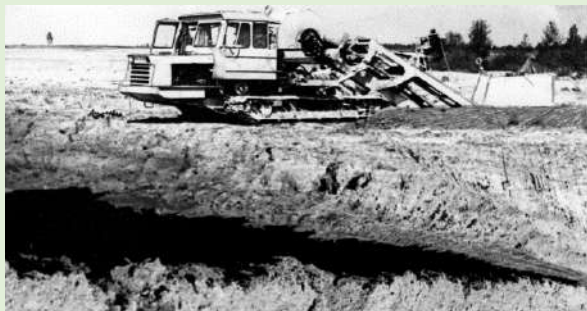
Механизированная очистка каналов экскаватором управления ЭМС. 1979 г.
