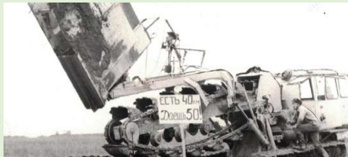
Экскаватором ПМК-2 уложено 40 км дренажа. Установлен щит с надписью: «Есть 40! Дашь 50!». 1980 г.
